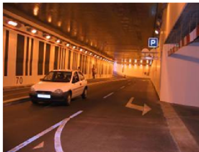
Castelo Branco (Túnel / entrada parque subterrâneo)
