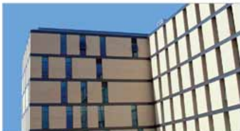
Hospital Escola Universidade Fernando Pessoa Arq. Luis Pinto de Faria e Arq. Miguel Faria Correia
